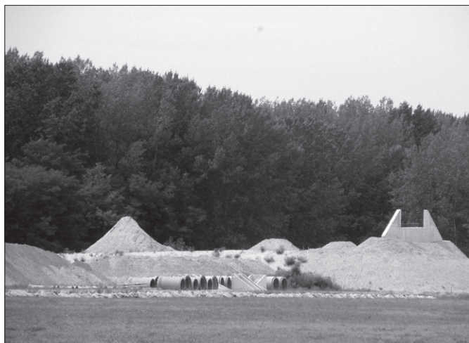
A Jász úti felüljáró így néz ki jelenleg
