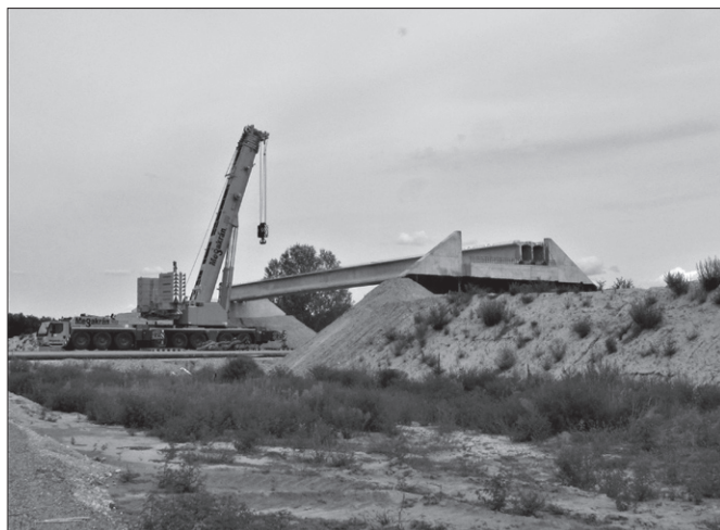
A Kocséri úti felüljáró építése is látványos, az óriási áthidalókat emelik a helyükre
