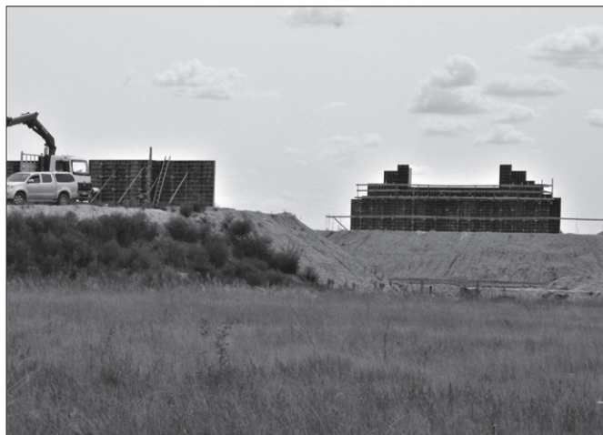
A Kossuth majori felüljáró építése
